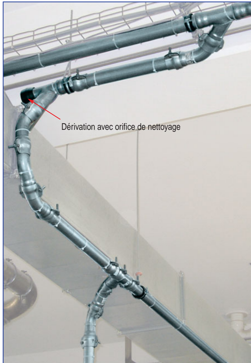
Raccord d'aspiration par passage des tuyaux par le sol
